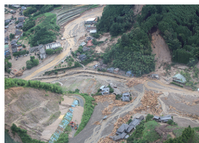
朝倉市松末地区の被害状況 （兵庫県消防防災航空隊提供）
