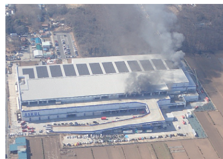
火災時の建物の状況（2月16日12時頃） （埼玉県防災航空隊提供）
